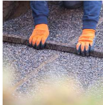
02. Preparación de la base con una solera de grava
