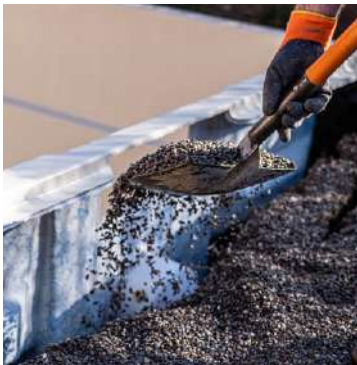
05. Rellenado de los laterales con grava
