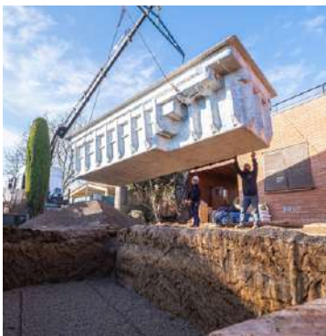
03. Colocación de la piscina en el agujero
