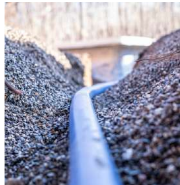
06. Instalación de tuberías
