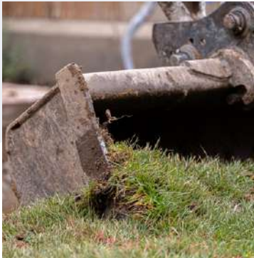
01. Excavación de la superficie de tierra
