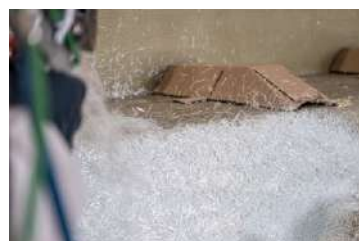
06. Proyectado final con fibra de vidrio y resina exclusiva
