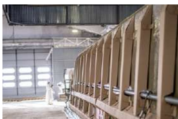
05. Colocación de refuerzos verticales y horizontales
