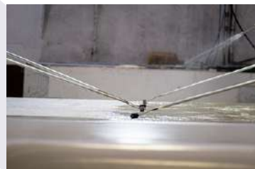
03. Aplicación de la capa de barrera química de alta resistencia para la prevención de ósmosis
