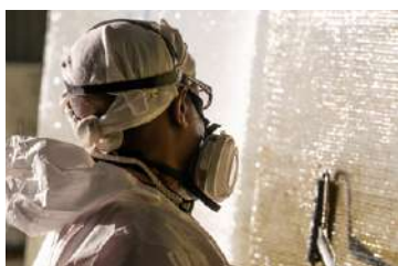
04. Aplicación manual de la fibra de vidrio y la resina
