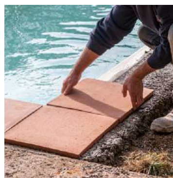
08. Colocación del borde perimetral
